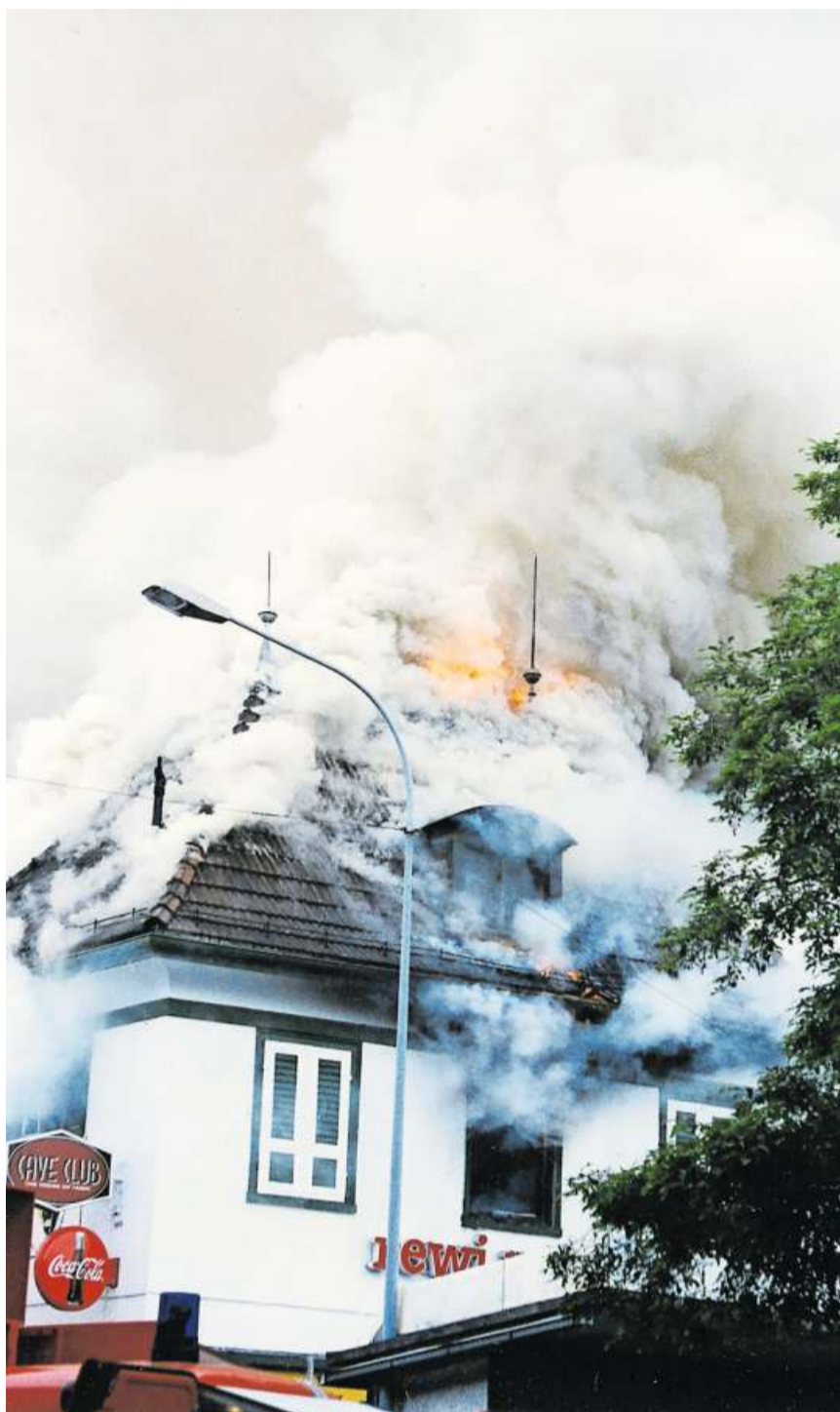
Im Juni 1998 wurde das damalige Hotel Landhaus durch einen Brand weitgehend zerstört. Inzwischen musste es der Überbauung beim Bahnhof weichen.
