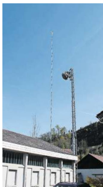
Die geplante Antenne ist in Necker ausgesteckt. Bild: Martin Knoepfel
